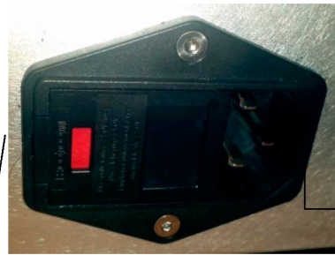
Plassering av systemsikringer
